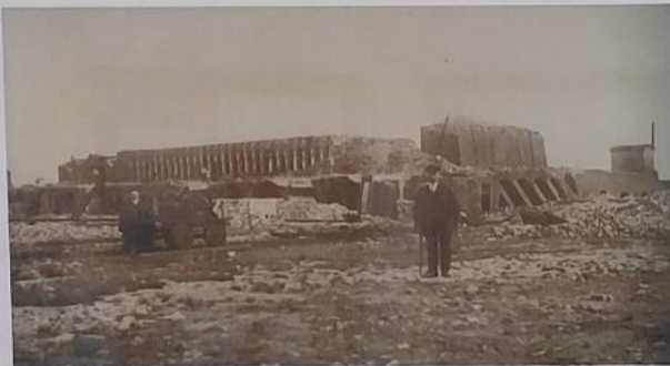
Abriss der Kokerei am Schacht III
