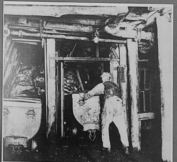
Förderung am Blindschacht
