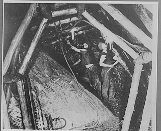
Ausbau in der steilen Lagerung
