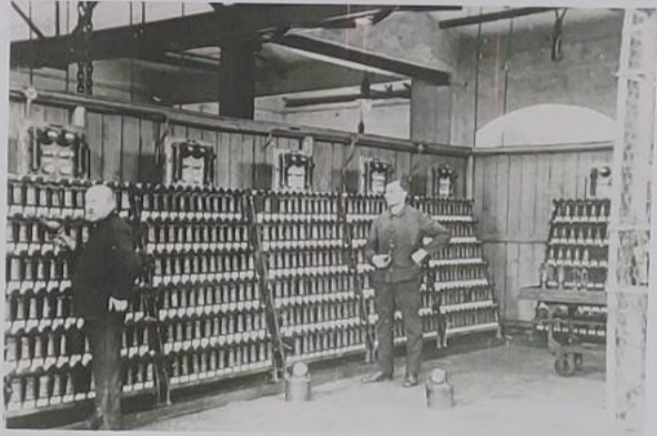
In der Lampenstube am Schacht 3
