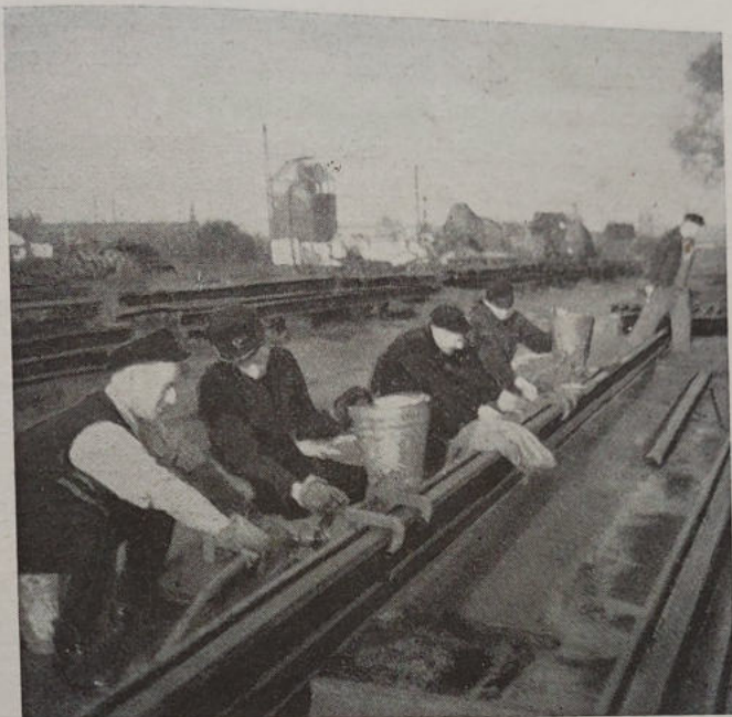
Die Rote bei Gleisarbeiten
