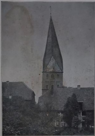
Der schiefe Kirchturm; das Wahrzeichen der Stadt Kamen.
