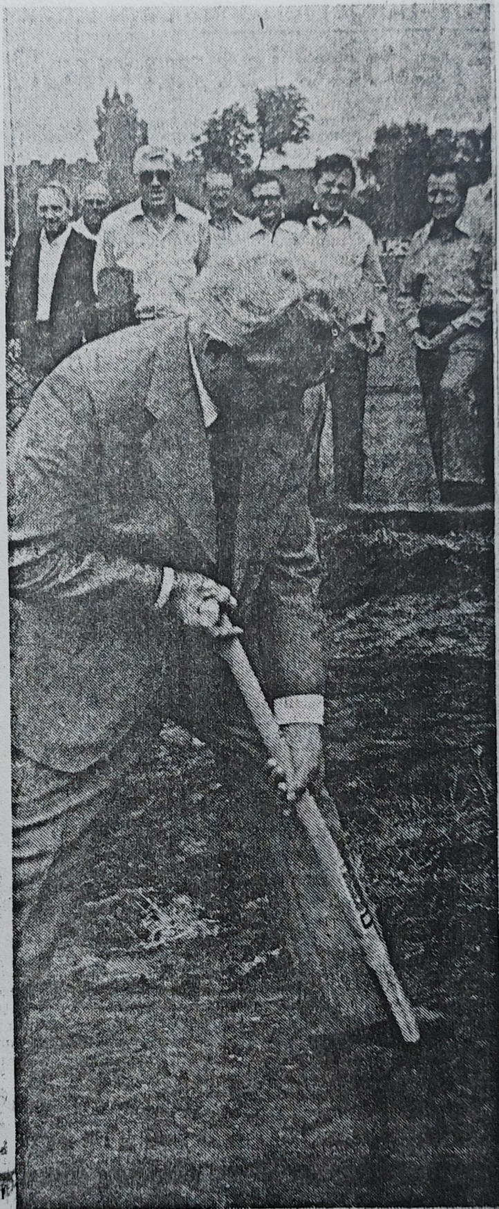
Mit gewohnter Routine tat Erich Göpfert den ersten Spatenstich. Der Freibadausbau in Massen konnte beginnen. (Bild: Richter)
